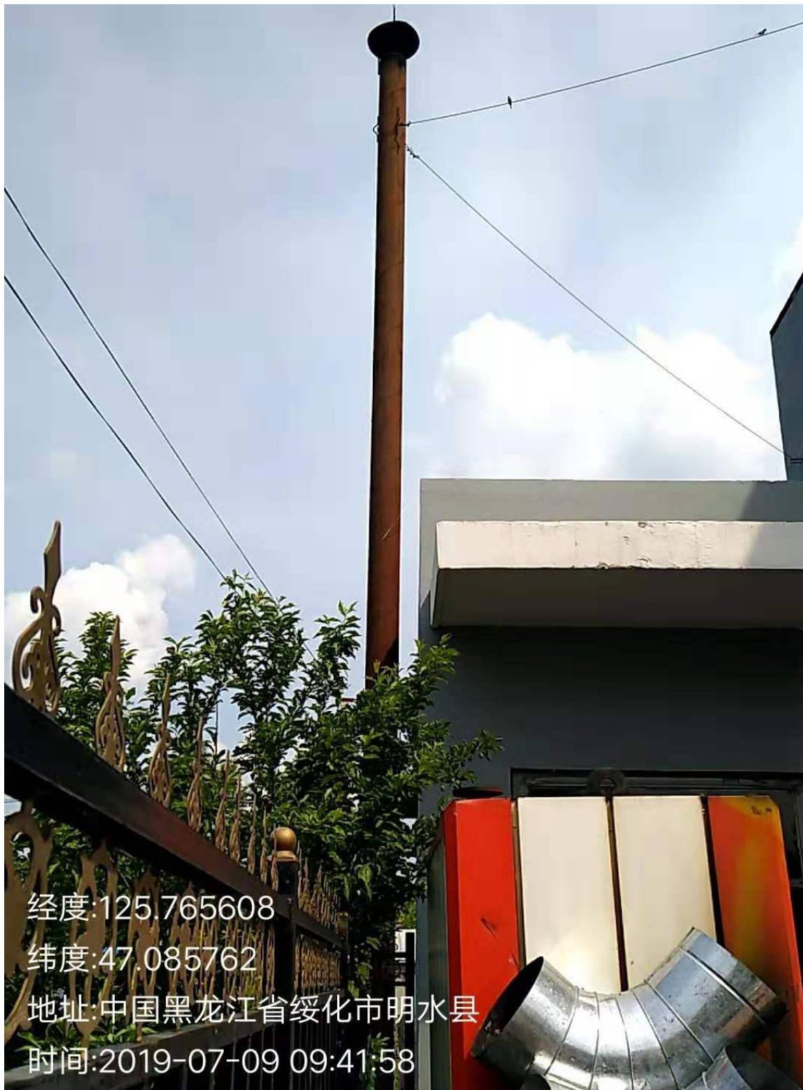
附图：锅炉烟尘高空排气筒
