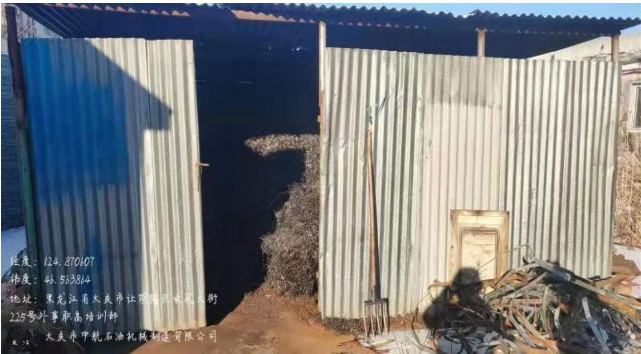
固体废物暂存间
